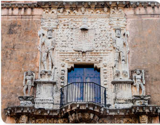
Figura 3.48 Fachada del Palacio Montejo en Mérida, Yucatán.
